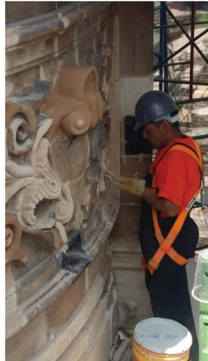
*Como parte del proceso de restauración fueron atendidos los elementos metálicos procediendo a la liberación del acabado existente, la estabilización del metal mediante la aplicación de ácido tánico al 5%, la limpieza mediante hexametáfosfato de sodio y integración de un color acorde al tono que fue detectado posterior a las calas estratigráficas.*
